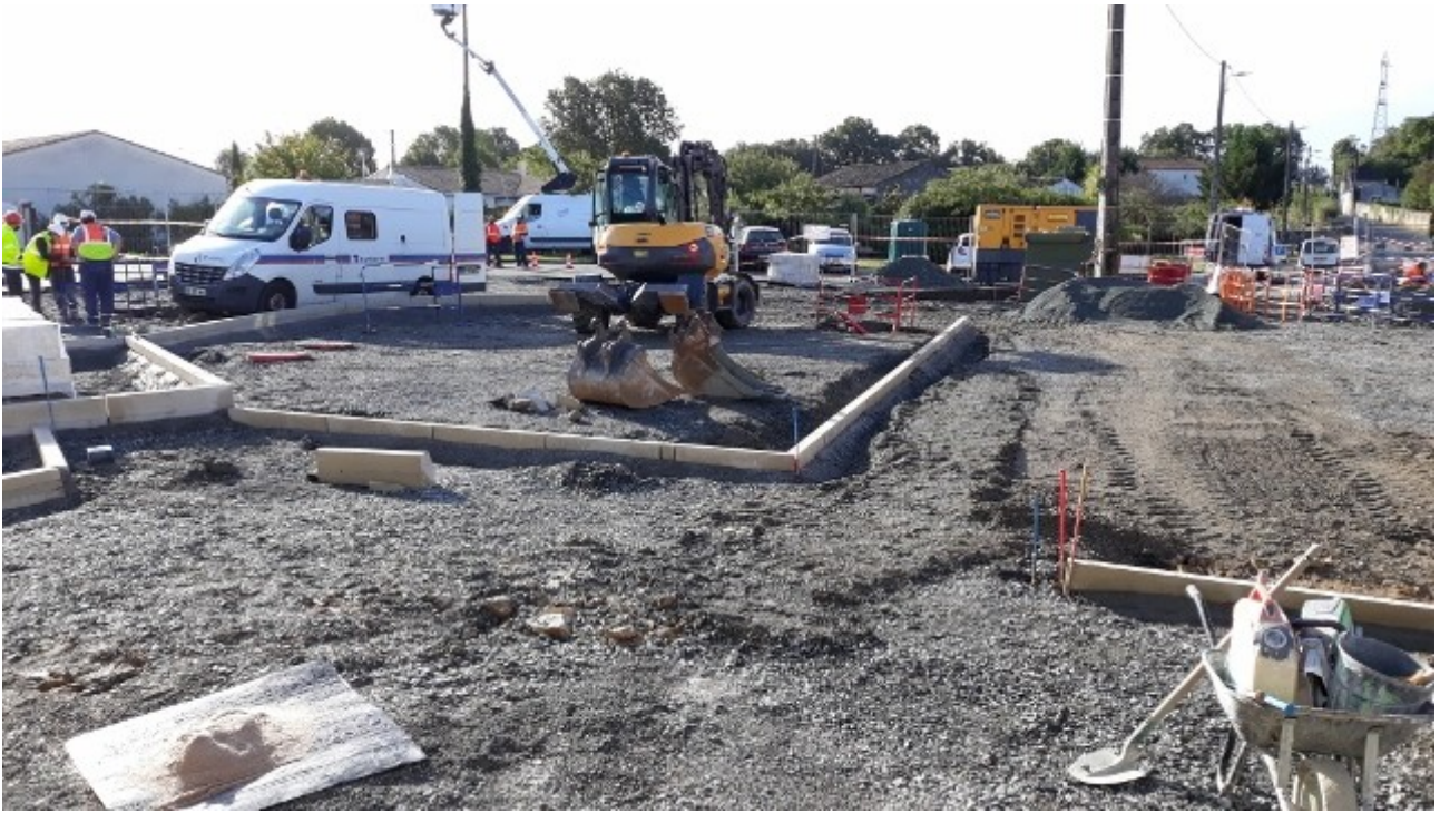
Ils installent les bordures.
