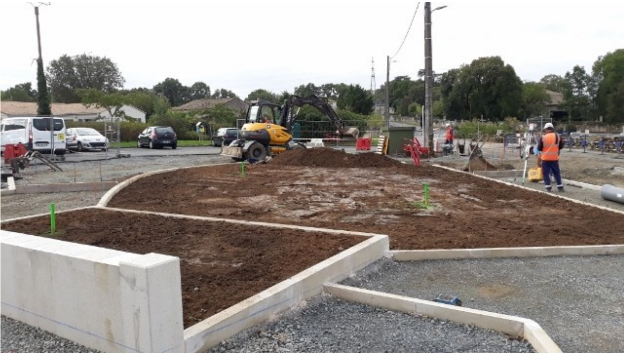
Maintenant il y a de la terre dans les trous et entre les bordures.
