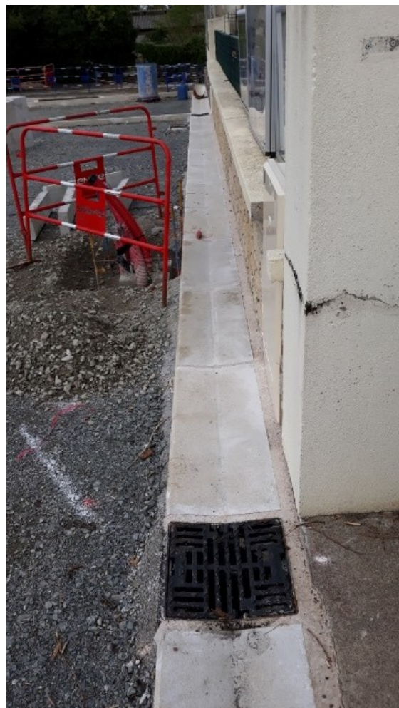
Le caniveau a été posé
